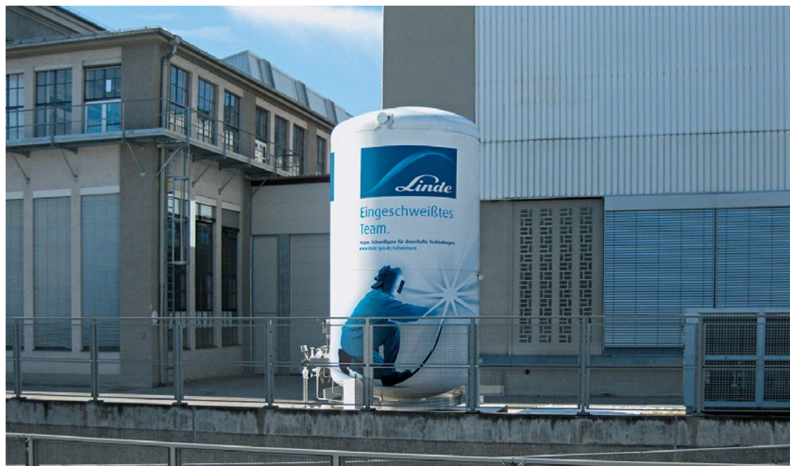
Billedet viser en lagertank med gas i flydende form hos en af Lindes kunder.
